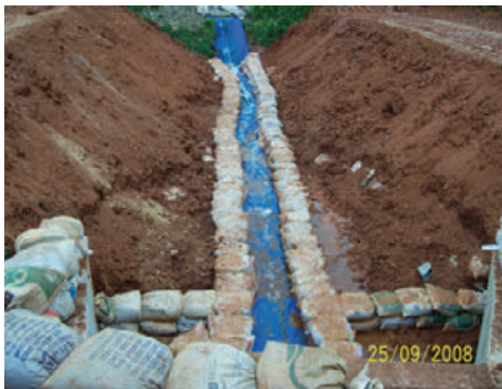
Figura 3 – Disciplinamento do fluxo de águas com linhas de sacaria e lona plástica para evitar contato direto com o solo. (Fonte: Fernando Kertzman)
