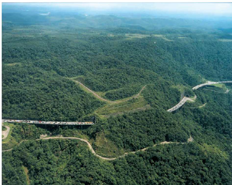
Figura 1 – O emprego pioneiro dos conhecimentos de Geologia de Engenharia sobre a dinâmica das encostas naturais da Serra do Mar levou a que se privilegiassem túneis e viadutos na concepção do projeto da Rodovia dos Imigrantes, com a menor interferência possível no terreno natural. (Foto Ecovias)
