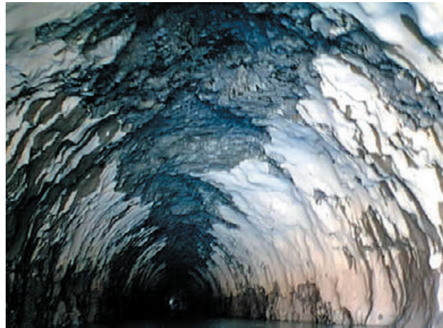
Figura 3 – Arranjo geral da obra. (Foto arquivo Nelson Infanti Jr.)
