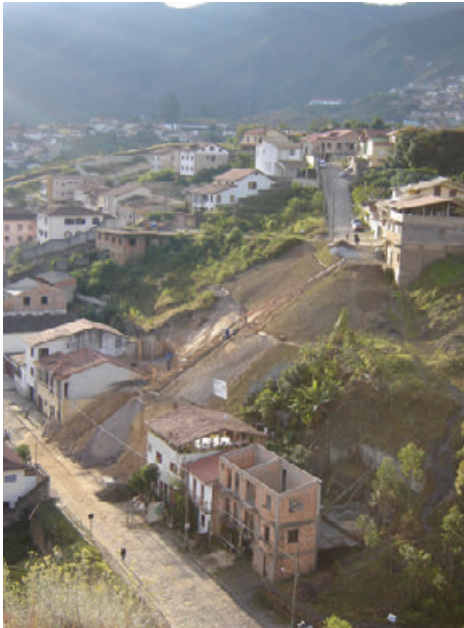
Figura 6 – Execução da obra de reconfiguração da encosta. (Foto F. G. Sobreira)
