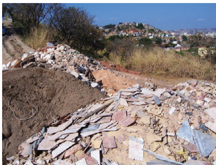
Figura 3 – O entulho inerte de construção civil sendo disposto para o preenchimento da ravina. (Foto do Autor)
