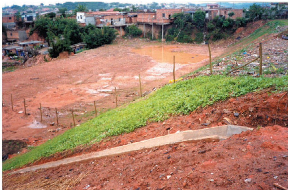
Figura 3 – Foto mostrando o primeiro patamar após conclusão dos serviços de terraplenagem. (Foto arquivo Edézio T. Carvalho)
