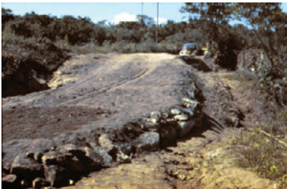
Utilização de técnicas simples, materiais naturais locais e mão-de-obra intensiva na recuperação de estradas vicinais de terra. Pelotas (RS). (Foto IPT)
