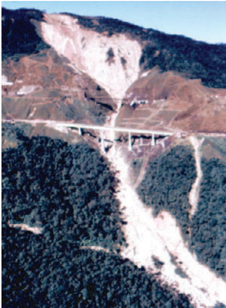
Famoso escorregamento da Grotta Funda, de difícil controle e seguidas recorrências, iniciado por escavações para implantação de antigo viaduto da Estrada de Ferro Santos–Jundiaí na Serra do Mar (SP). (Foto do Autor)
