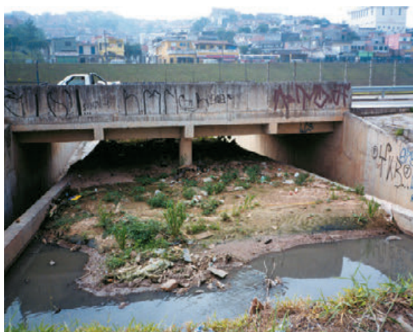
Figura 9 – Tomada d'água do "piscinão" do córrego Saracantã, em São Bernardo (SP), totalmente assoreado com pouquíssimo tempo de operação. (Foto do Autor)
