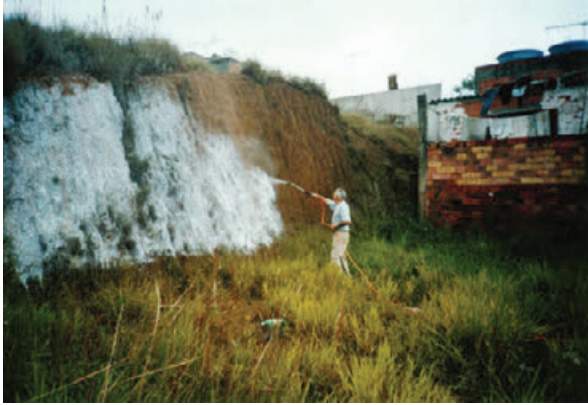
Mangueira de 30 metros do pulverizador motorizado permitindo um grande raio de alcance. (Foto do Autor)
