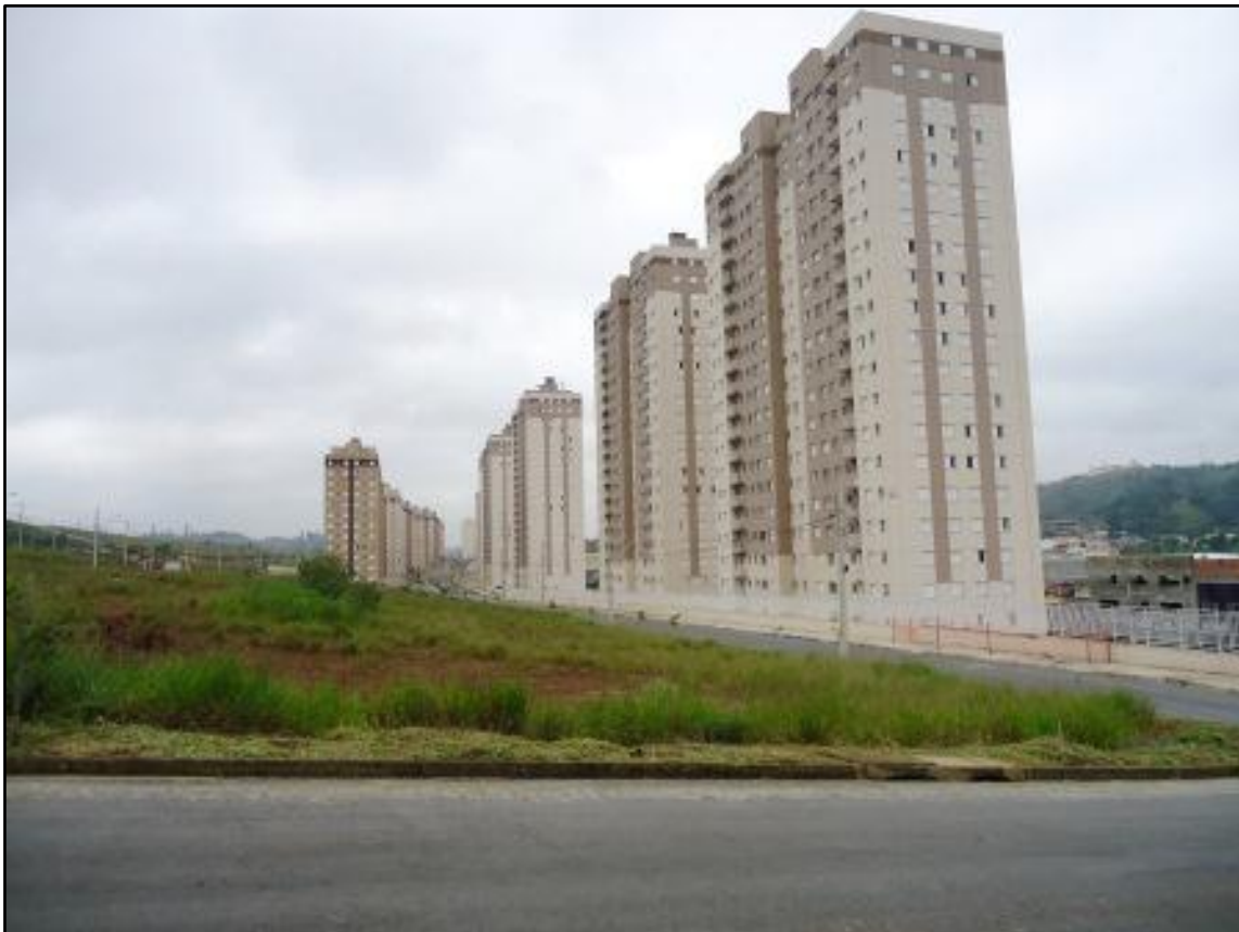
Fig 13 - Grande empreendimento imobiliário que teve uma segunda fase avançando sobre a faixa do vale aí presente, coincidente com o alinhamento cárstico Polvilho - Natura, apresentou grande concentração de vazios na interface solo/rocha, o que veio a demandar extensivo tratamento geotécnico por injeções de calda de cimento e adoção de estacas hélice contínuas como sistema de fundação. Foto ARSantos.
