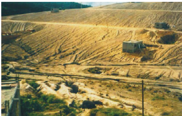
Erosão urbana: uma de suas principais causas constitui-se no parcelamento do solo com a retirada da vegetação e do solo superficial e o longo tempo de exposição aos agentes erosivos até uma futura consolidação da urbanização. Região Metropolitana de São Paulo. (Foto IPT)
