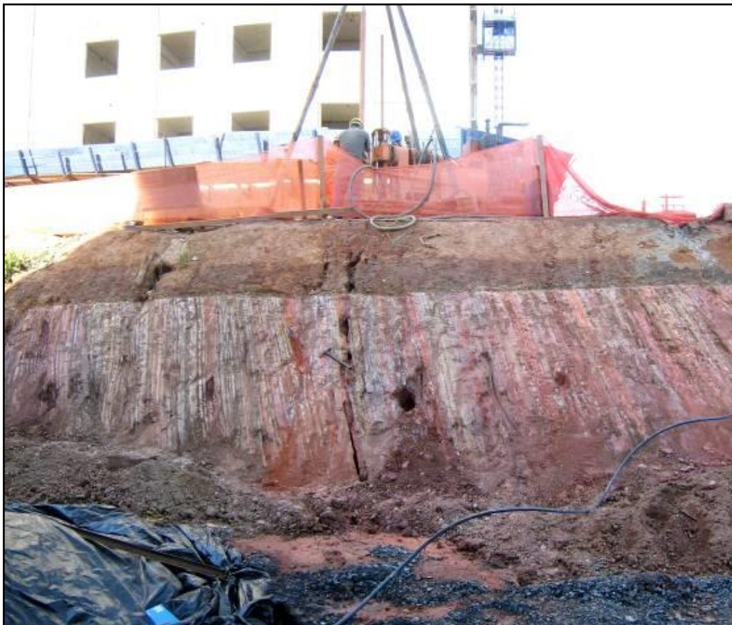
Fig 6 - Notar a orientação praticamente vertical dos diversos estratos xistosos metamorfozados. A rocha calcária se encontra-se em média de 30 - 80 metros de profundidade a partir desse nível. Foto ARSantos
