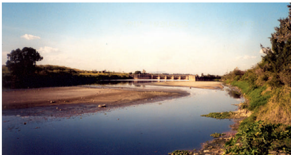
Figura 8 – Aspecto do assoreamento do Rio Tietê a jusante da Barragem da Penha na capital. (Foto do Autor)
