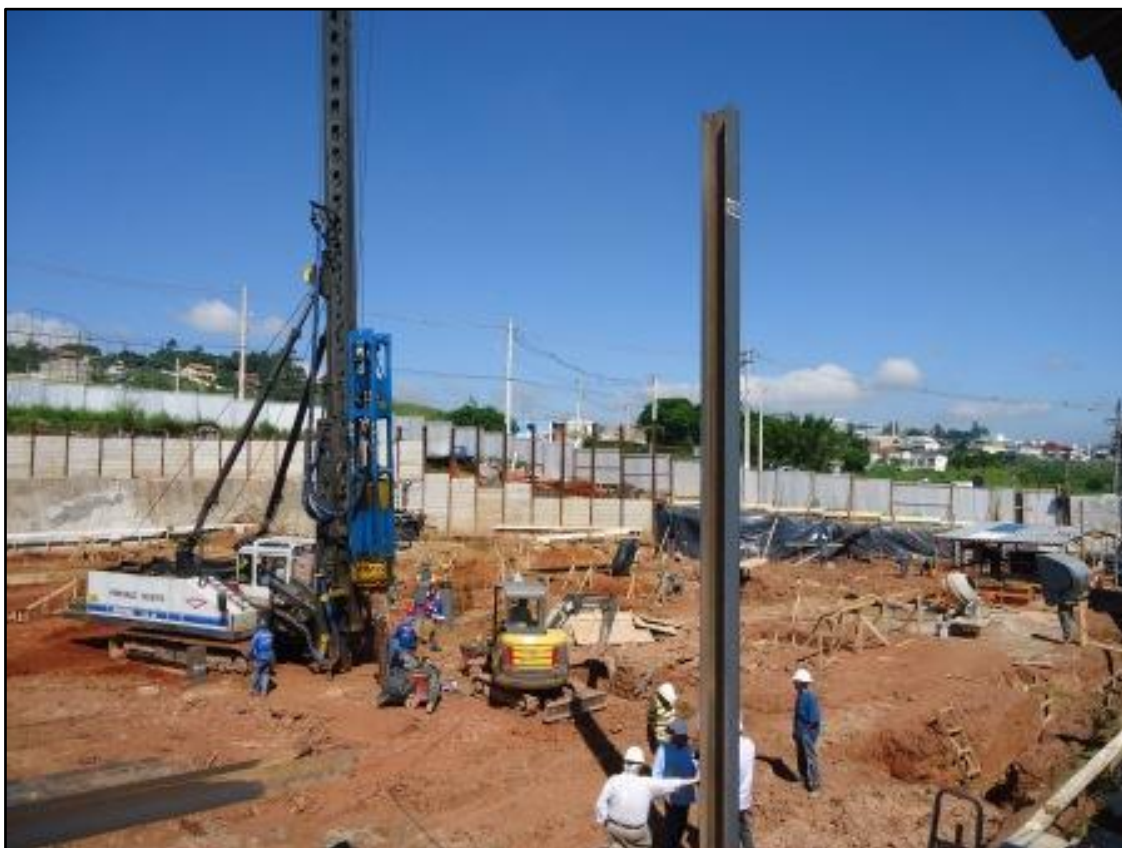
Fig 16 – Empreendimento imobiliário ocupando gleba com concentração de vazios cársticos. As condições geológicas levaram à opção por estacas metálicas cravadas e tratamento dos vazios cársticos com injeção de calda de cimento. Foto ARSantos
