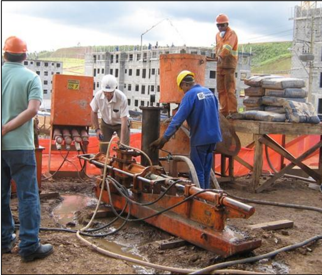
Fig 19- Bomba pneumática utilizada para a injeção de calda de cimento com misturador acoplado. Foto ARSantos.
