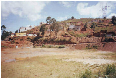
Vista geral da Vila Operária mostrando o intenso movimento de terra associado à implantação dos arruamentos e do processo de ocupação/escavação lote a lote. (Foto do Autor)
