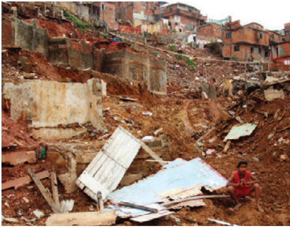
As grotas, feição geomorfológica naturalmente de alta instabilidade, constituem cenários comuns para a instalação de áreas de risco em situações de ocupação urbana desordenada e sem qualquer critério técnico. Favela Paraisópolis, em São Paulo. (Foto do Autor)
