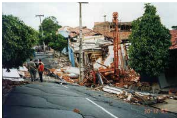
Afundamento cárstico. Teresina – PI
