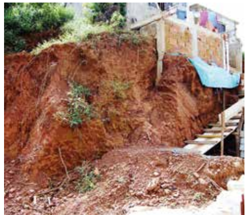
A temerária obsessão pela produção de platôs planos através de uma sucessão de cortes e aterros. São Paulo – SP. Fotos: ARSantos
