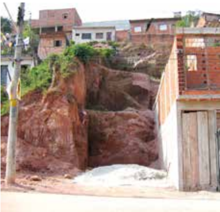
A temerária obsessão pela produção de platôs planos através de uma sucessão de cortes e aterros. São Paulo – SP. Fotos: ARSantos
