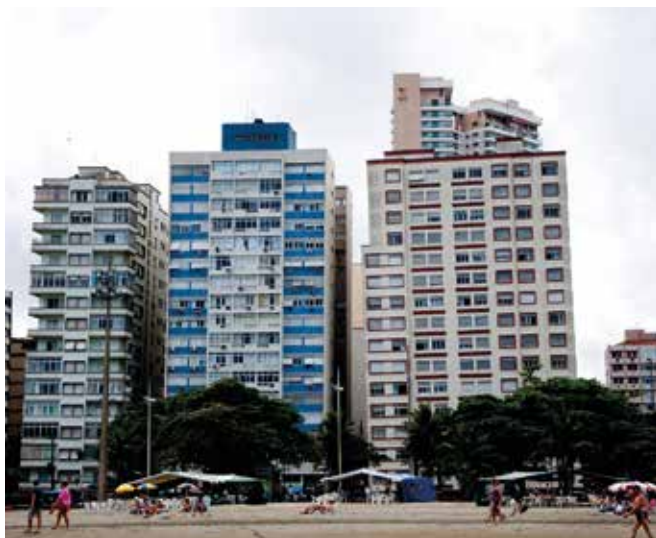
Inclinação de edifícios devido a recalques em camadas de argilas moles. Santos – SP. Foto: Felipe Barcelos
